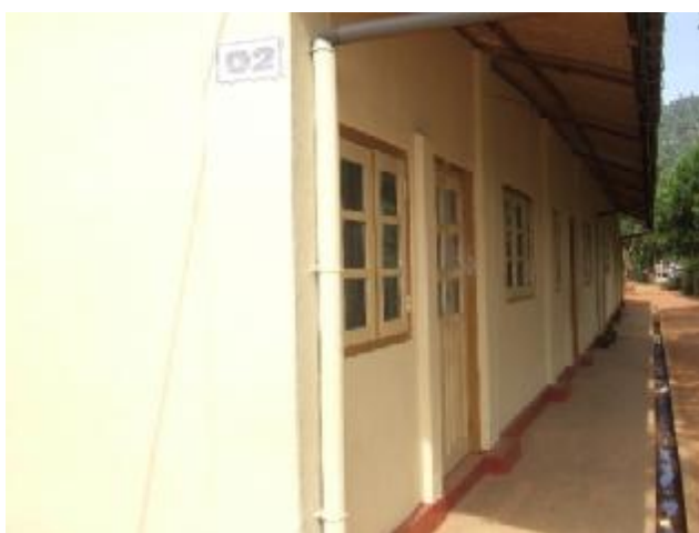
Umfassende Renovierungsarbeiten an der Rahatungoda Schule...
