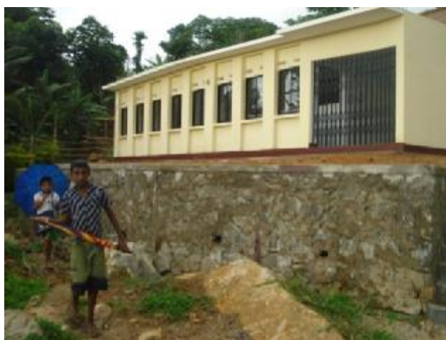
...sowie der Bau der Hunugala Schule konnten bereits abgeschlossen werden. (Foto: Plan Sri Lanka)
