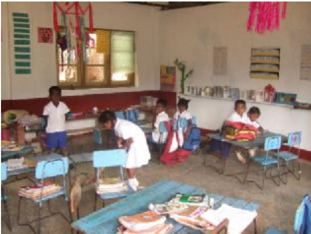
An der Rahatungoda Schule wurden umfangreiche Renovierungsmaßnahmen vorgenommen. (Foto: Plan Sri Lanka)
